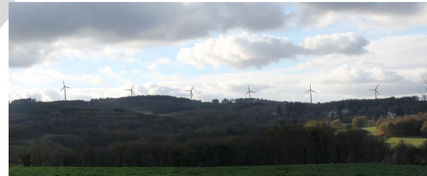
Bersac-sur-Rivalier : 5 à 7 éoliennes de 3MW
